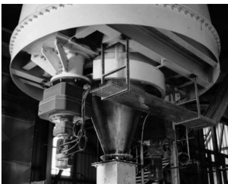
Рисунок 5. Механическая выгрузка силоса сырьевого гипса
