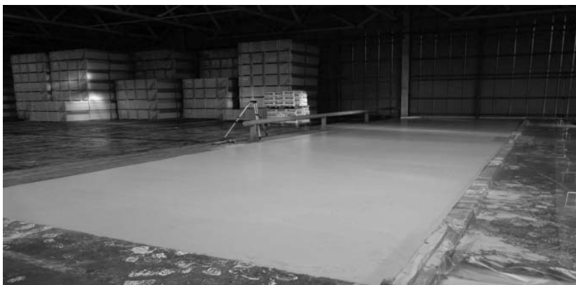
Рисунок 5. Готовый пол в промышленном складе завода на основе высокопрочного конверсионного гипса
