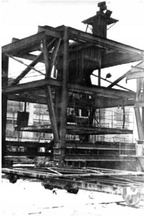
Рис. 1. Формующая установка объёмных блок-комнат из ГЦП бетонов (Киев 70-ые годы)
