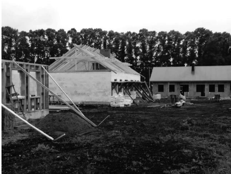
Рисунок 3. Строительство двухквартирных домов из пеногипса и гипсокерамзитовых блоков.
