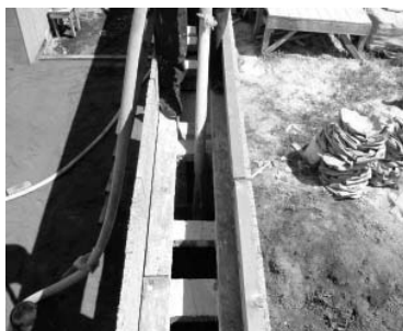
Рисунок 1. Заливка монолитного пеногипса в конструкцию каркасной наружной стены
