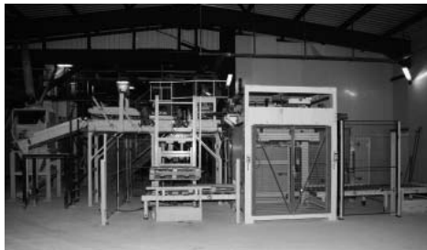
Рисунок 15. Установка укладки мешков на поддоны
