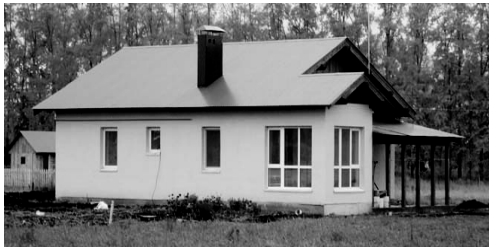
Рис.1. Одноквартирный жилой дом в п. Иглино с деревянным каркасом и заполнением наружных стен монолитным пеногипсом.
