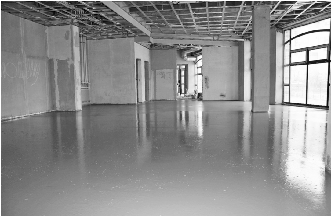
Рис.9. Готовый наливной пол из смеси «Нивелир Русеан»
